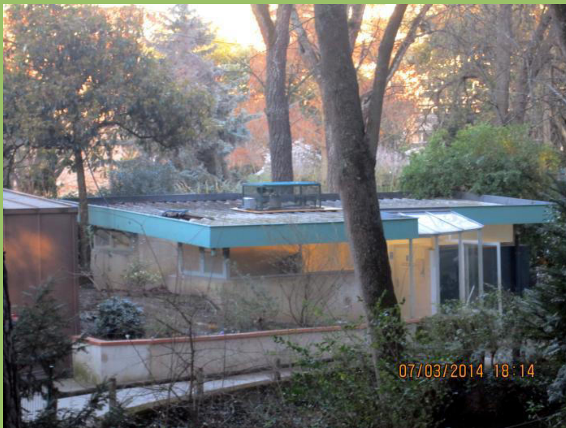
cage installée sur le toit le 07/03/2014
